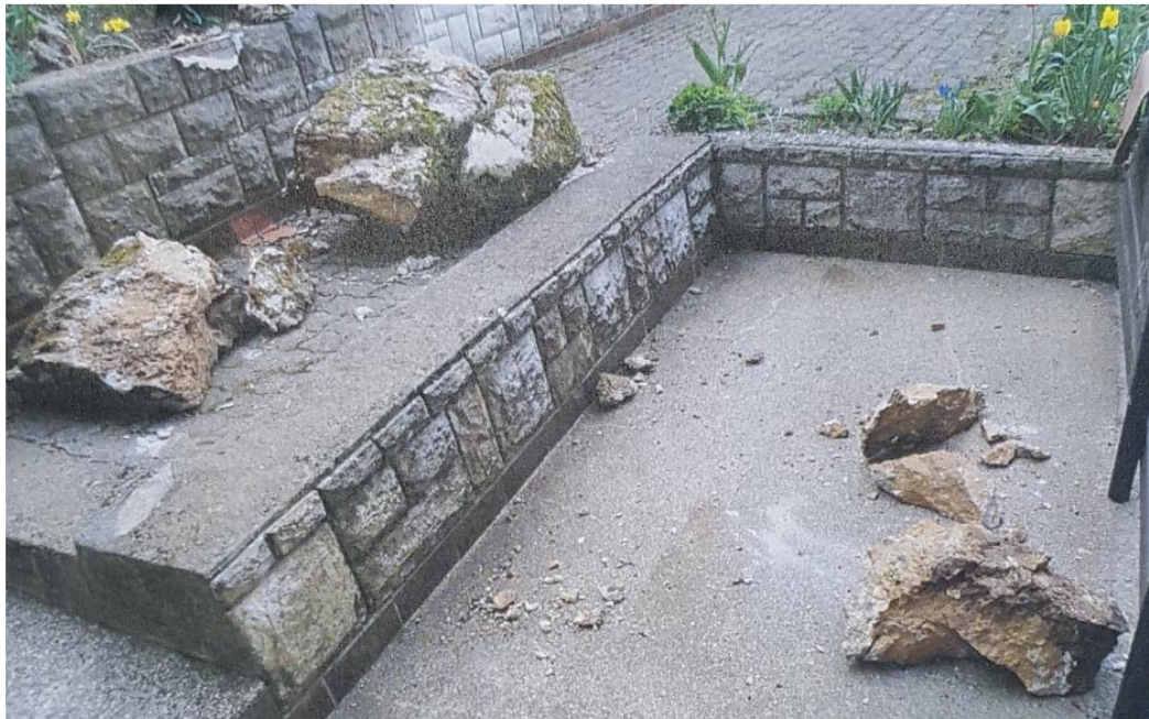
Slika 2 Skalni podor na zidanih terasah nad objektom Partizanska pot 3.
