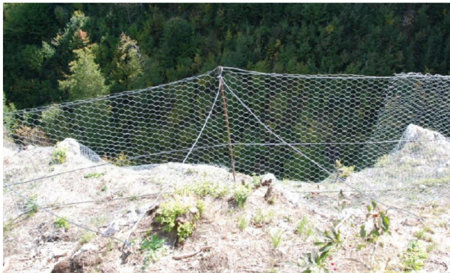
Slika zgoraj: necertificirana začasna varovalna ograja.
